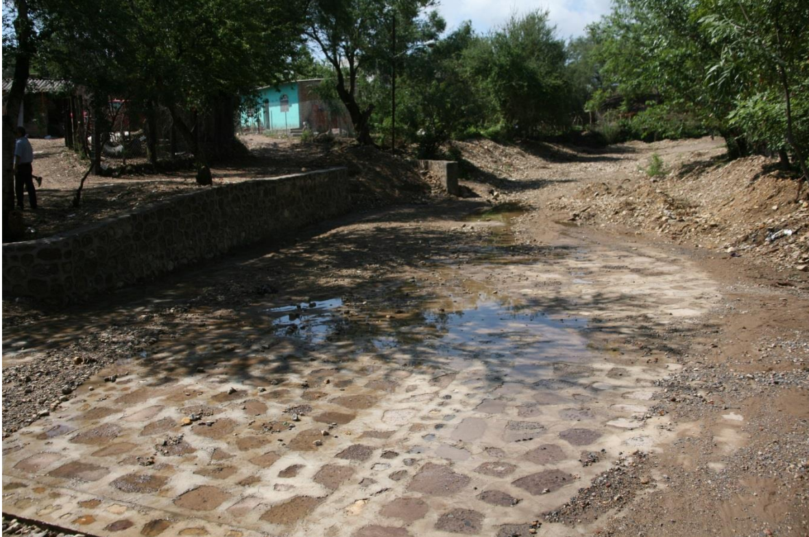
Terminación del vado en el arroyo que delimita a San Ignacio Portes gil y Ojo de Agua, y proceso del vado en el Arroyo Santa Anita en Cabecera Municipal
